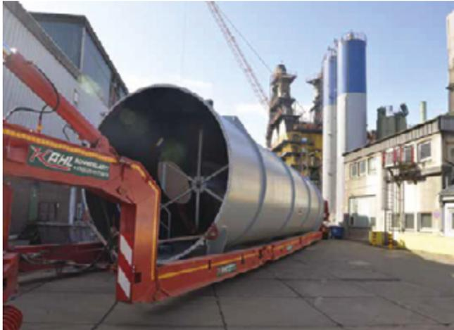
Mit dem Projekt in Hamburg werden zielgerichtete Ventilationsöffnungen geschaffen. Die Rohre sind dafür vorgesehen, über 1 Mio. m<sup>3</sup>/h Luft abzusaugen und in einer modernen Anlage zu filtern. Der Umbau läuft aktuell neben dem Normalbetrieb der Hütte.
