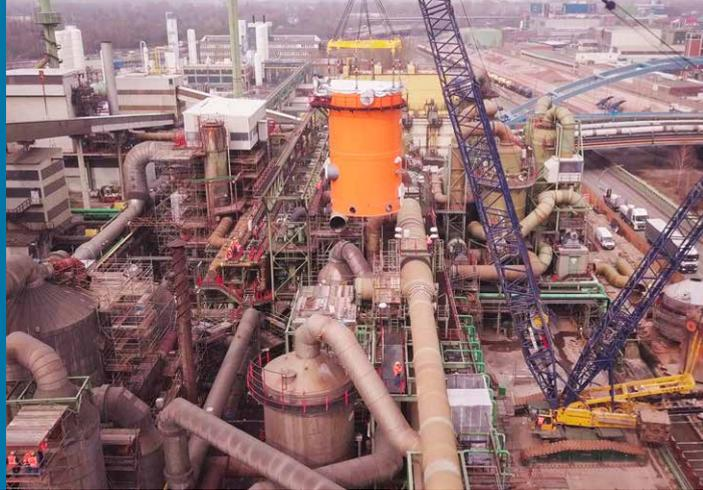
Die heißen Abgase des Schwebeschmelzofens werden zunächst in einem Abhitzeessel gekühlt, dabei wird ein 60-bar-Dampf erzeugt.
